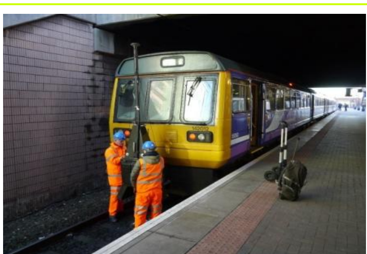
Montaż SPAN na elektrowozie.
